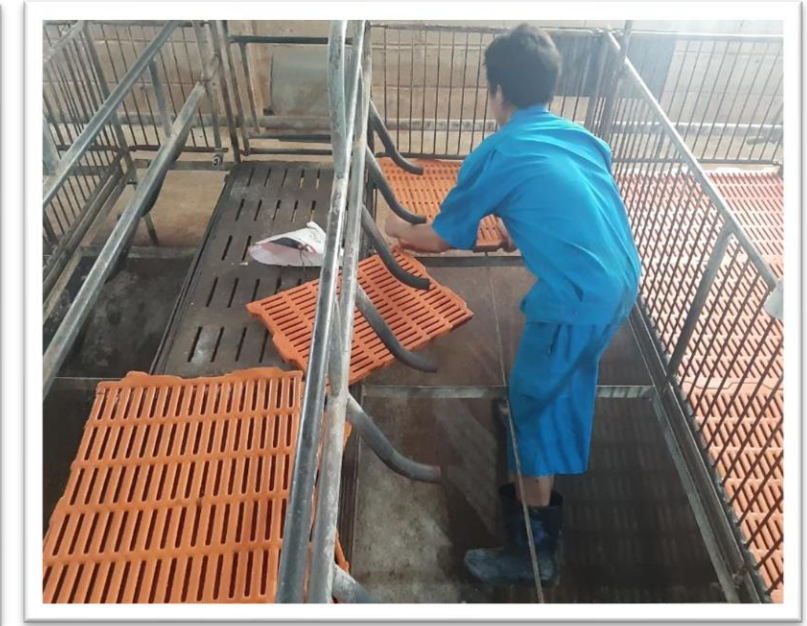
Lắp đặt trở lại
